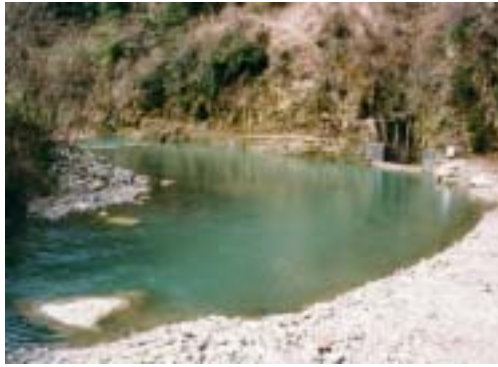
辰巳用水の東岩取水口（ダムで破壊されようとしている） 右手に取水口、左奥に頭首工（堰）がある。
