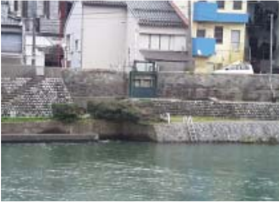
犀川大橋近くの大野庄用水取水口。この左に金沢市の工業用水の取水口が作られ、港近くへパイプで水を送る計画でした。
