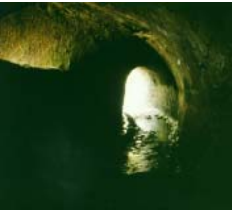
辰巳用水の水トンネル
